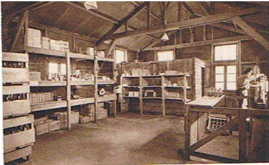
Foyer (fabrication des sodas)
